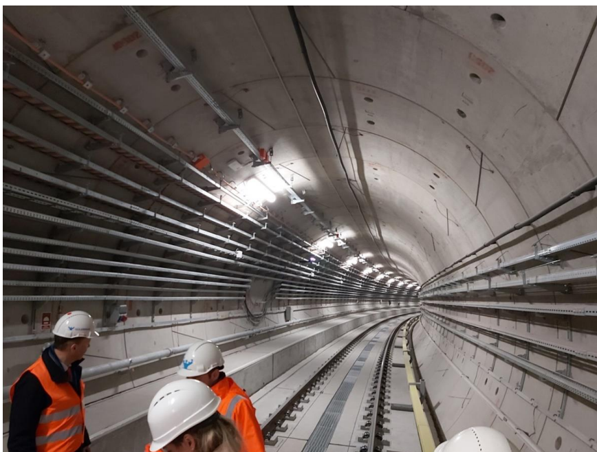
Obr. 5: Technická exkurze v nově budovaném varšavském metru, trasa linky 2, zprovoznění je naplánováno na květen 2020
